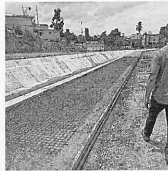
Colocación de base y malla electro-soldada para ciclovía
