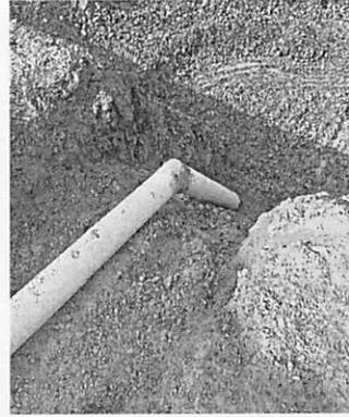
Colocación tuberías de 8" para interconexión en Sector Las Terracitas
