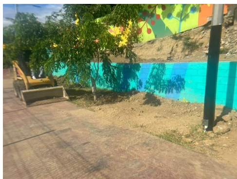
Relleno Talud Hawai
