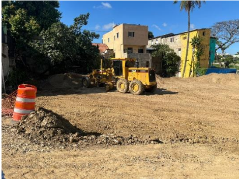
Relleno con material de mina, Parqueo Luis Vera
