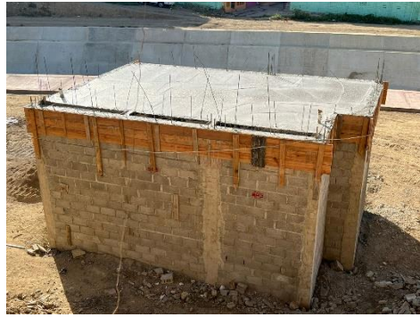
Construcción baño, Los Solares
