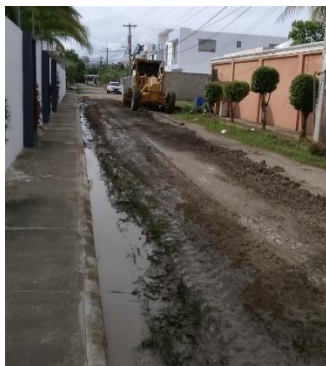
Acondicionamiento, Sector Villa María
