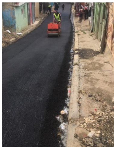
Reposición Asfalto, Barrio Los Santos
