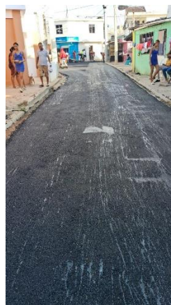
Reposición Asfalto, Barrio La Terracita
