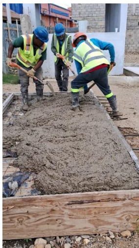
Hormigonado Losa Hoyo de Puchulo
