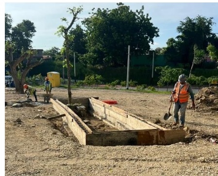
Construcción jardinera, Hoyo de Puchulo
