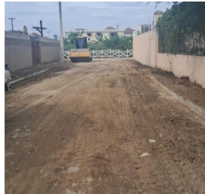
Acondicionamiento, Sector Villa María
