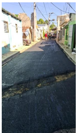
Reposición Asfalto, Barrio La Terracita
