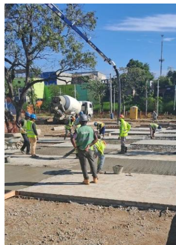
Hormigonado Losa Hoyo de Puchulo
