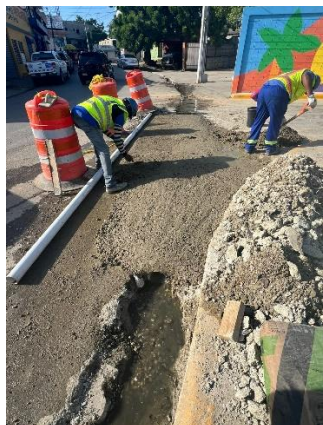
Construcción Baden Acceso Parque B
