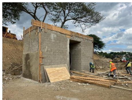
Construcción baño Los Solares
