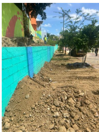
Relleno Talud Hawai
