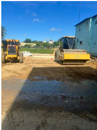
Relleno con material de mina, Parqueo Luis Vera
