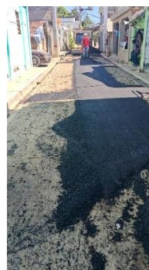
Reposición Asfalto, Barrio La Terracita
