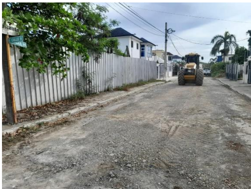
Acondicionamiento, Sector Villa María
