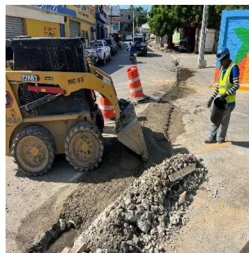
Construcción Baden Acceso Parque B
