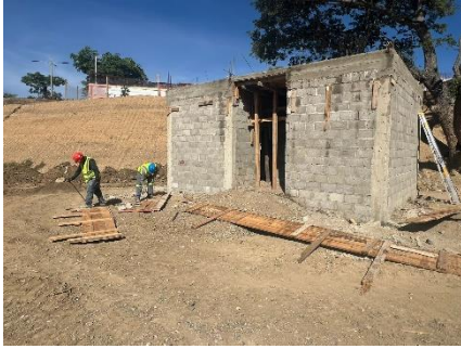
Construcción baño, Los Solares
