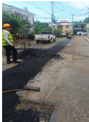
Reposición Asfalto, Barrio Los Santos
