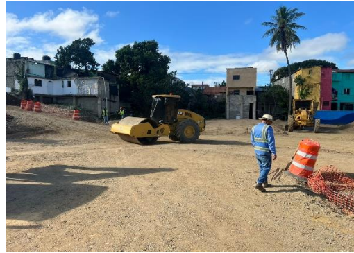
Relleno con material de mina, Parqueo Luis Vera
