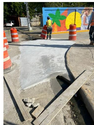
Construcción Baden Acceso Parque B
