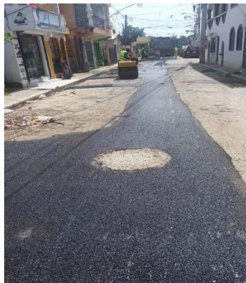
Reposición Asfalto, Barrio Los Santos
