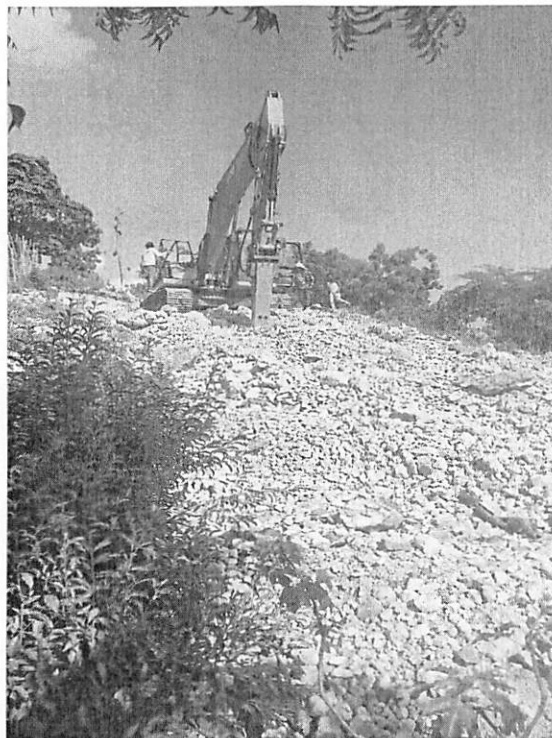
Trabajos en la línea de impulsión
