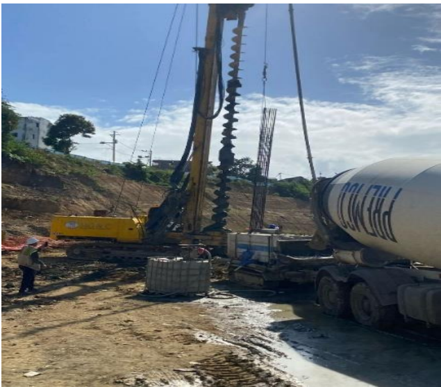
Hormigonado de pilotes puente curvo metálico
