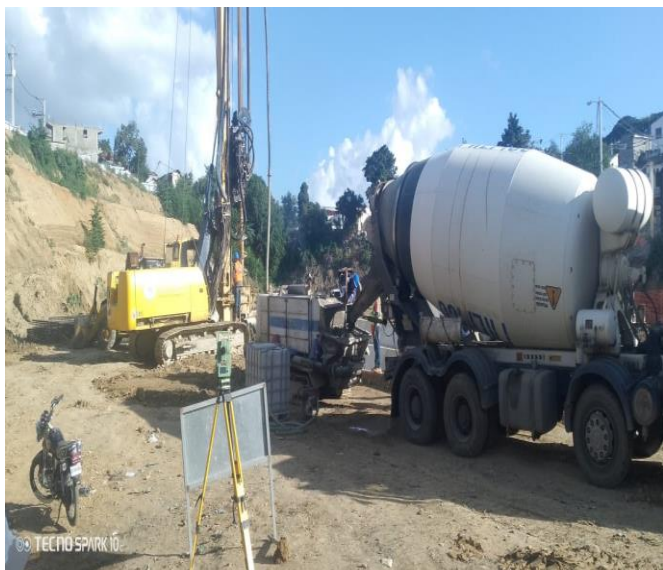
Hormigonado de pilotes puente curvo metálico
