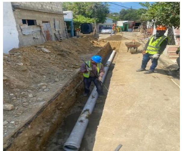
Colocación de tubería sector las cayenas
