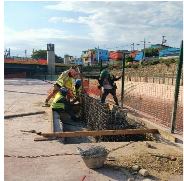
Hormigonado de zapata puente
