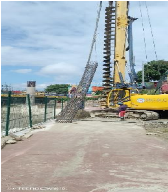
Pilotes Viga Doble T
