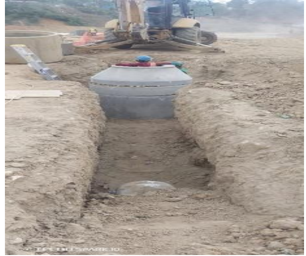
Colocación de registros
