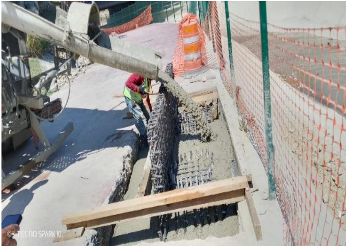
Hormigonado de zapata puente peatonal #2
