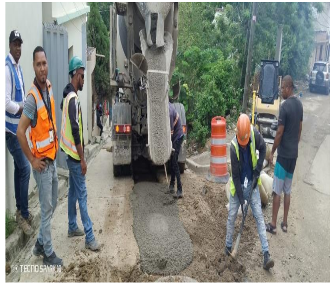
Reposición de hormigón sector las cayenas
