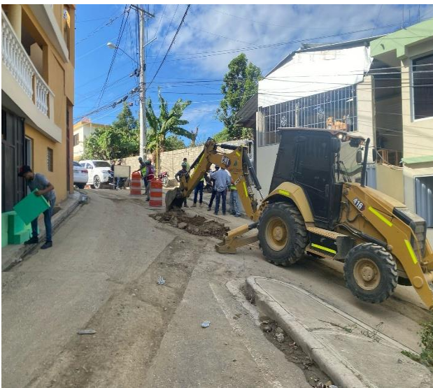
Colocación de registros
