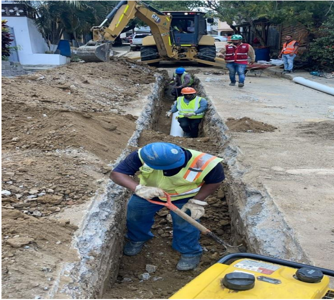
Colocación de tubería sector las Cayenas
