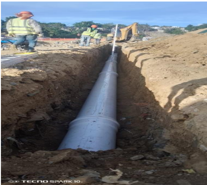
Colocación de tubería de 16" PVC en la colectora
