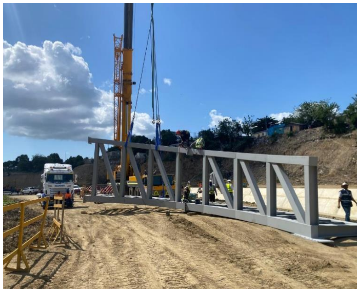
Puente Curvo Metálico #2
