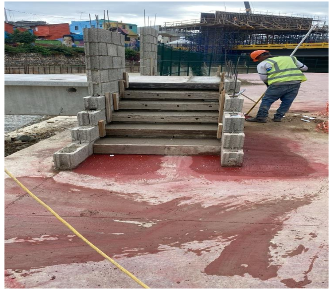
Rampa de acceso a puente peatonal
