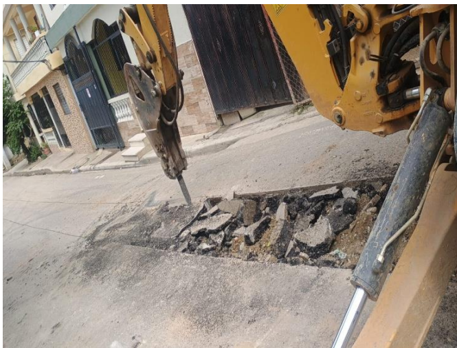
Demolición de asfalto las cayenas
