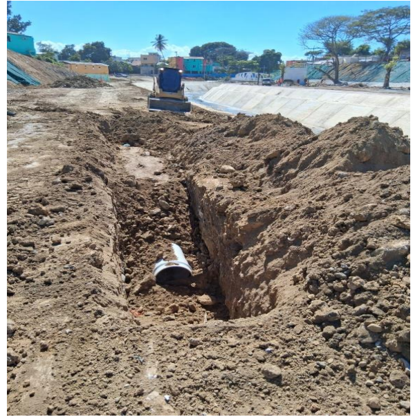
Colocación de tubería de 12" PVC
