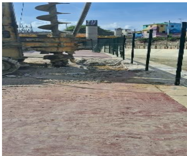
Perforación para pilote puente Viga T
