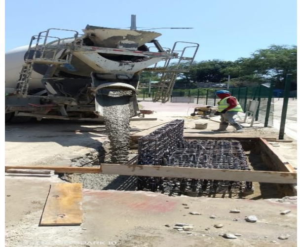
Hormigonado de zapata puente peatonal #2
