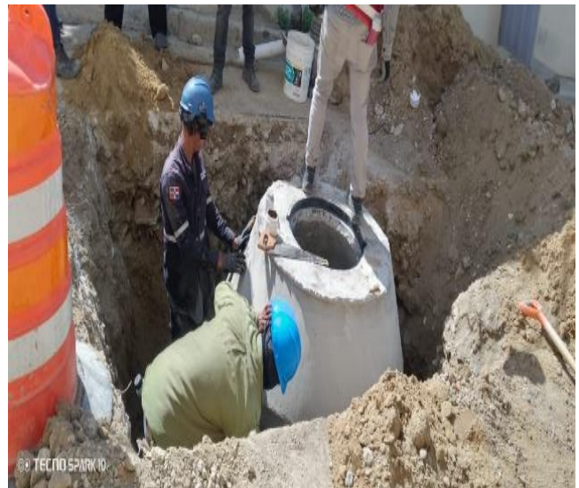
Colocación de registros
