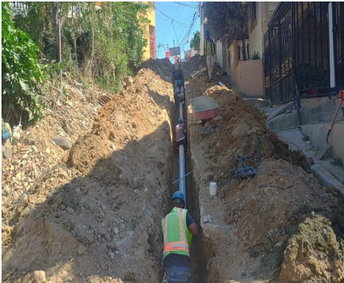
Tuberías sector las cayenas
