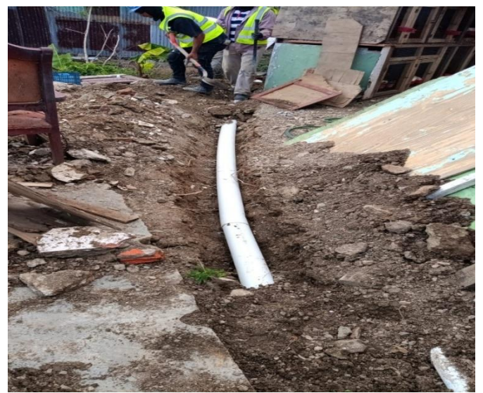
Reparación de avería
