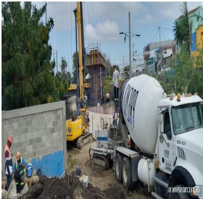
Hormigonado Pilotes Vigas Doble T
