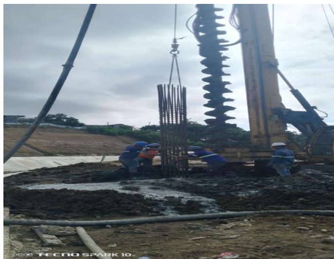
colocación de pilotes
