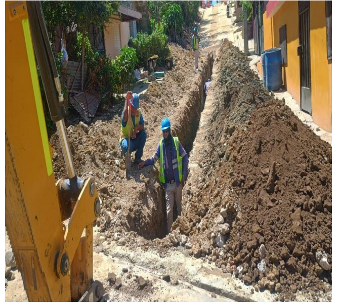
Colocación de tubería sector las Cayenas
