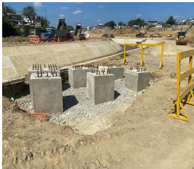
Zapata de puente curvo metálico
