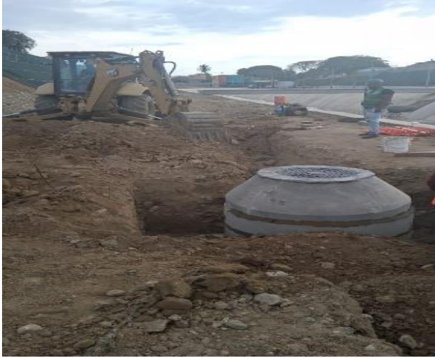
Colocación de registros
