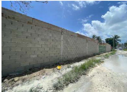
Imagen No. 105. Área de estación de bombeo No. 4 propuesta
