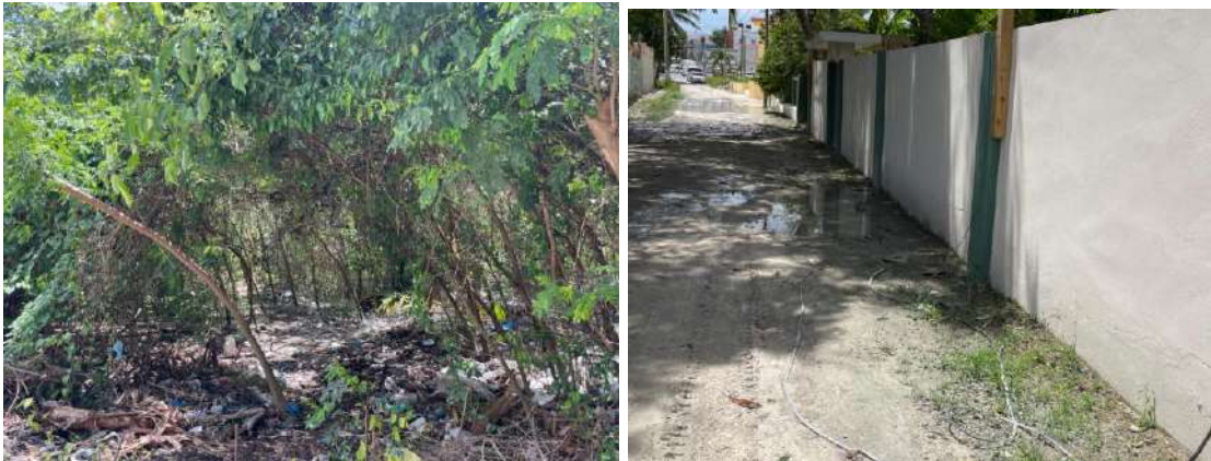
Imagen No. 106. Área colindante a la estación de bombeo No. 4 (izquierda) - Área frontal de la ubicación de la estación de bombeo No. 4 propuesta (derecha)
