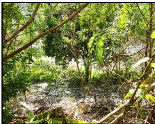
Imagen No. 43. Estación de bombeo No. 4
