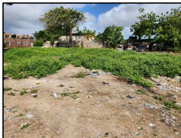
Imagen No. 46. Estación de bombeo No. 6
