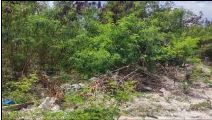
Imagen No. 43. Estación de bombeo No. 1
