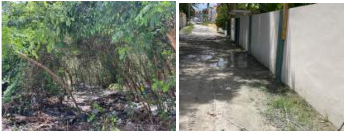
Imagen No. 109. Área colindante a la estación de bombeo No. 4 (izquierda) - Área frontal de la ubicación de la estación de bombeo No. 4 propuesta (derecha)
