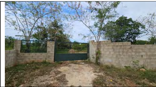
Foto 01: Ingreso a la propiedad.
