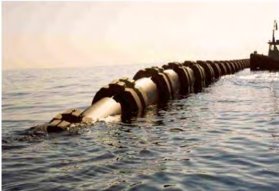
Figura 4.3.3.b Hundimiento de tubos de HDPE con collares de lastre fijados
