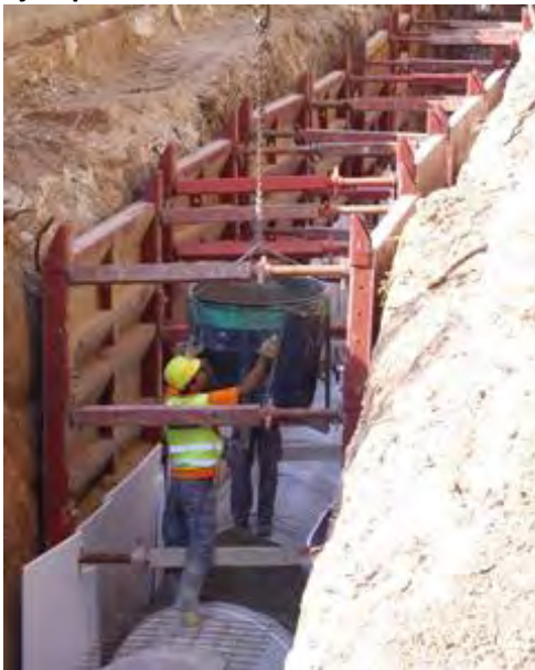
Figura 4.4.2.1.h Ejemplo de entibado metálico
