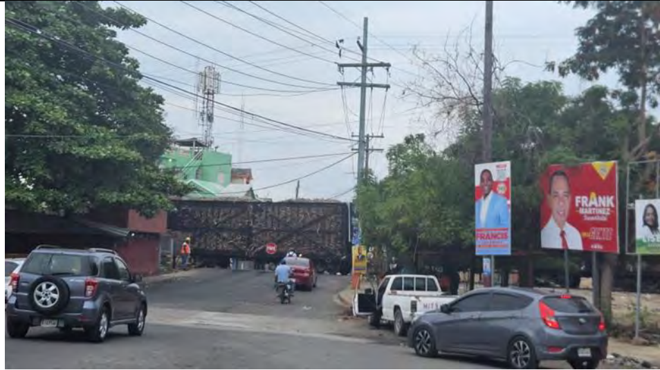
Foto 04: Detalle del cruce de la avenida con la vía del tren.
