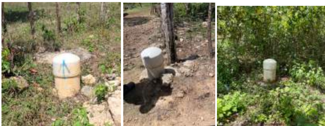
Imagen No. 115. Pozo existente en la coordenada UTM 19Q 549915 2064020 (izquierda), 19Q 550206 2063873 (Centro), 19Q 551438 2062520 (derecha)
