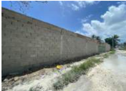
Imagen No. 108. Área de estación de bombeo No. 4 propuesta
