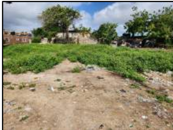
Imagen No. 49. Estación de bombeo No. 6
