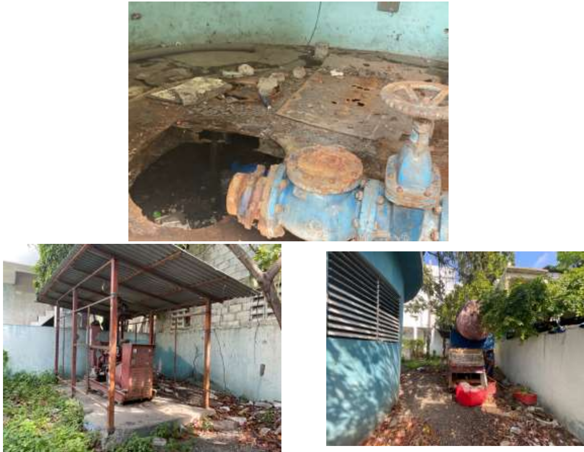
Imagen No. 39. Estación de bombeo No. 1
