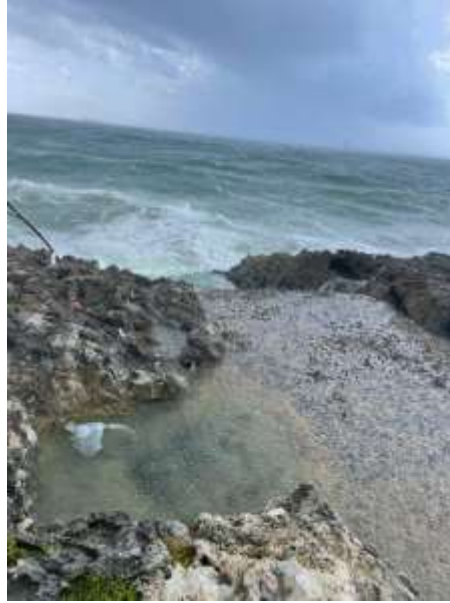
Imagen No. 25. Punto de descarga del PTAR al océano
