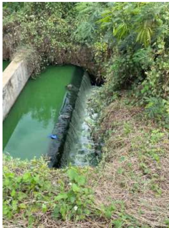
Imagen No. 37. Punto de salida de la PTAR hacia la descarga al océano
