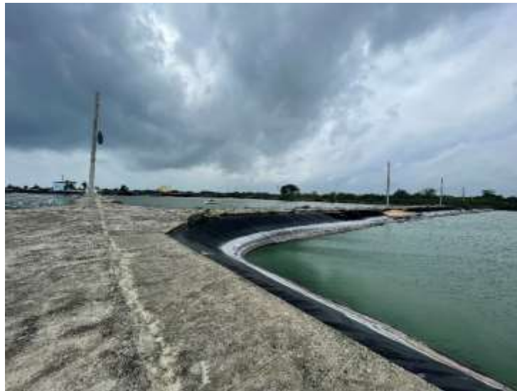
Imagen No. 32. Área de la PTAR actualmente
