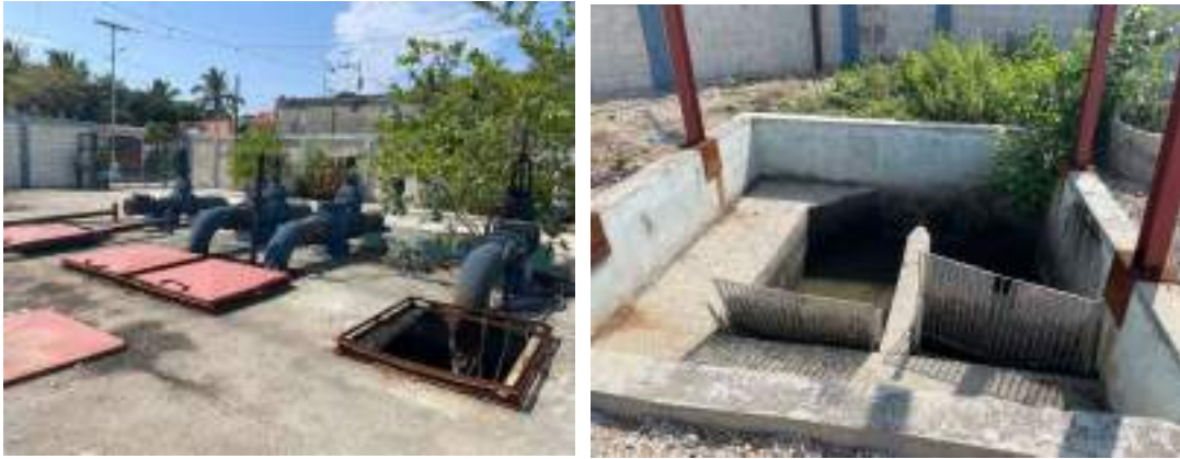
Imagen No. 28. Estación de bombeo No. 4 - Existente
