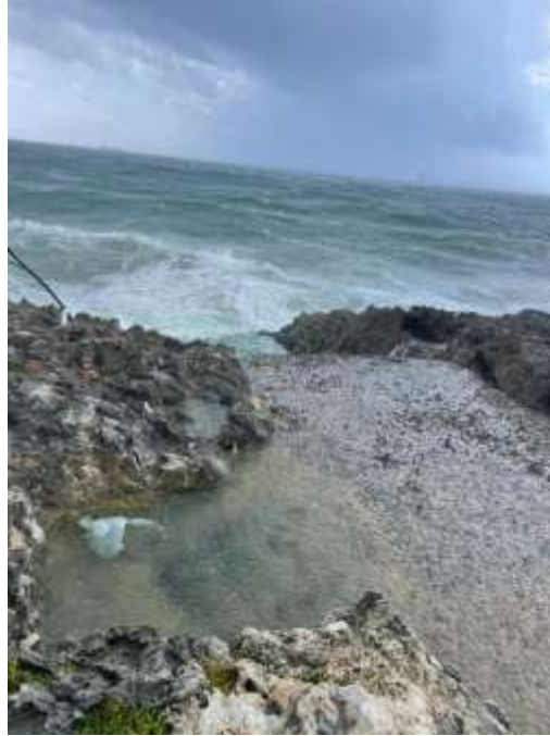
Imagen No. 38. Punto de descarga de disposición final del AR luego del tratamiento – al océano (al área protegida Arrecifes del Sureste)
