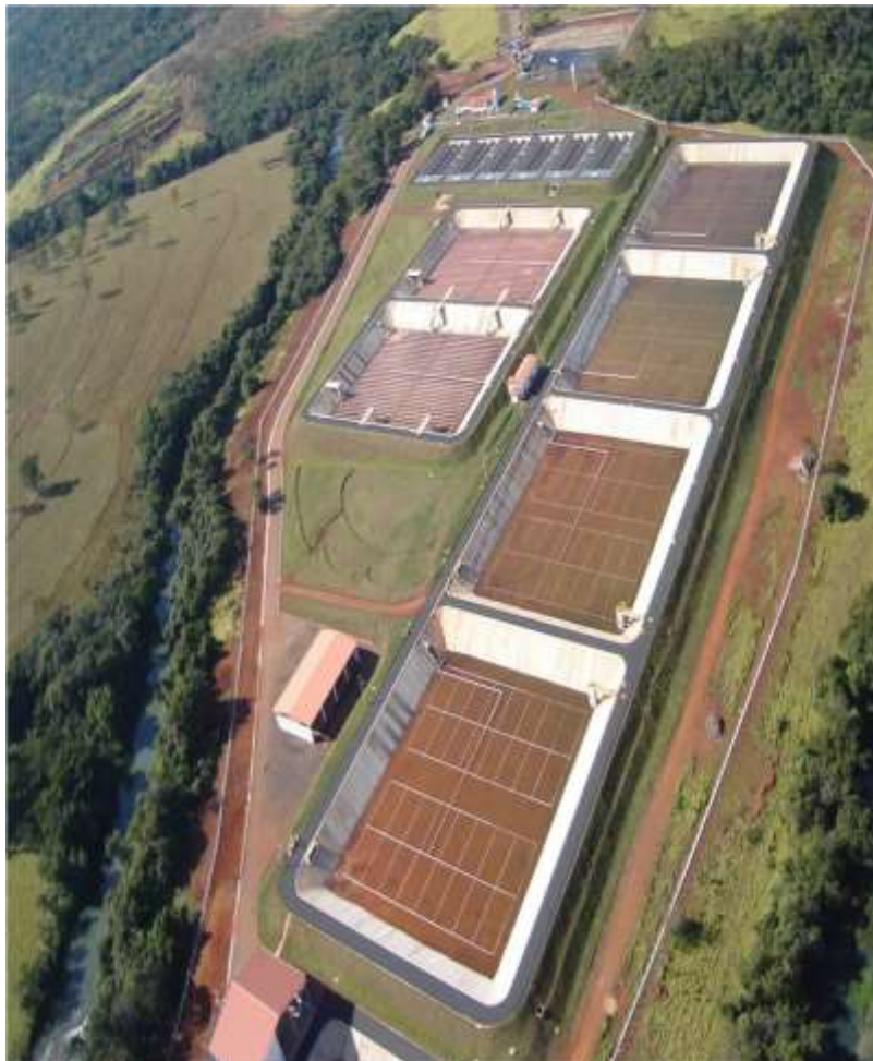
Figura 6- Planta de tratamiento de Uberaba, en la modalidad DPMC
