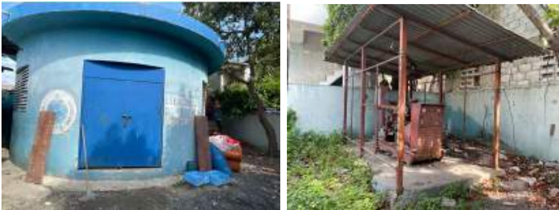
Imagen No. 26. Estación de bombeo No. 1 - Existente
