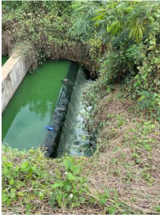
Imagen No. 33. Punto de salida de la PTAR antes de la descarga al océano
