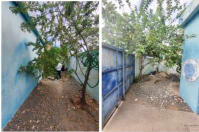
Imagen No. 62. Estación de bombeo EBAR 3 - Existente
