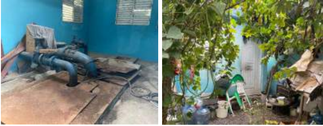
Imagen No. 27. Estación de Bombeo No. 3 - Existente
