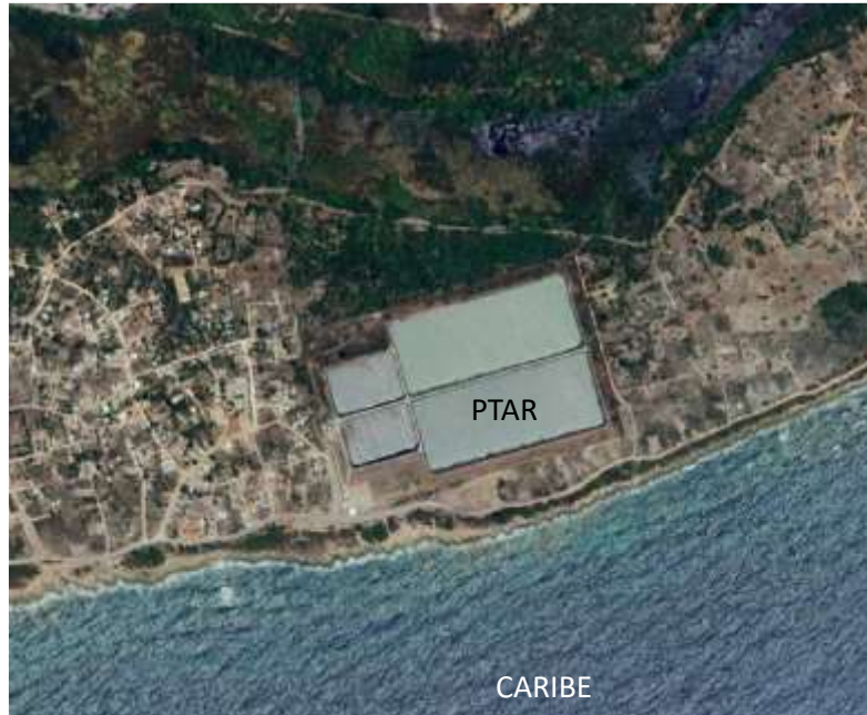
Imagen No. 4. Ubicación de la planta de tratamiento existente en el área urbana de San Pedro de Macorís
