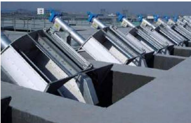
Los equipos de remoción de sólidos serán instalados en una estructura en hormigón armado. El esquema de la Alternativa 1 esta presentado en la figura 9.
