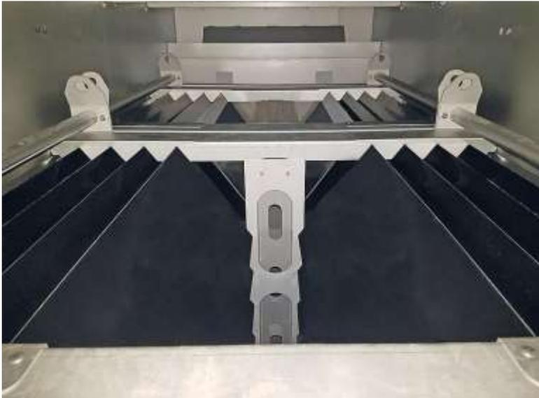
**3ª etapa - Retención de sólidos finos.** Después del tanque desarenador, el desagüe pasa por un sistema con tamices mecanizados, con tambor rotativo, con apertura de 1,5 mm. Los tamices con tambores rotativos son acoplados a un lavador y compactador de los detritos retenidos. La Figura 8 siguiente presenta un ejemplo de una instalación de tamices rotativos. Después del tamizado, el desagüe sigue para la etapa siguiente del tratamiento.
