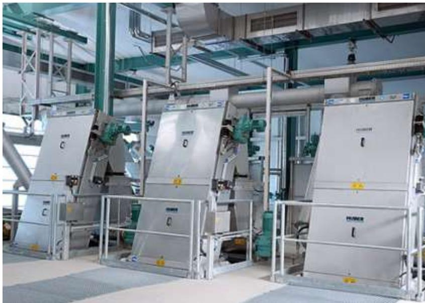
Imagen No. 7. Rejillas de barras mecanizada
