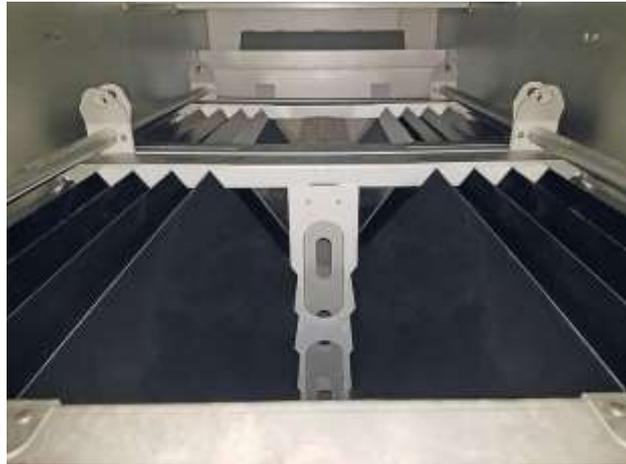
Imagen No. 8. Desarenador Lamelar, de fabricante Huber
