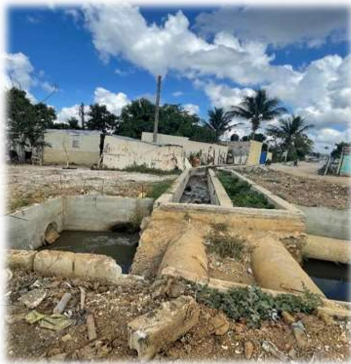
Imagen No. 29. Estado de la entrada de agua a la PTAR
