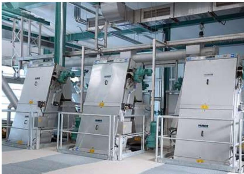
**2ª etapa - Retención de arenas y grasas.** La retención de las arenas y grasas presentes en el efluente se dará por medio de un desarenador. El tanque desarenador será del tipo en canal, que dispone de lamelas para mejorar la decantación.
