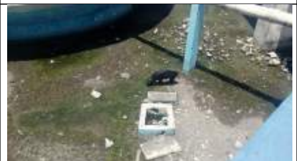
Foto 10: Desperfectos en urbanización e inundación de urbanización.
