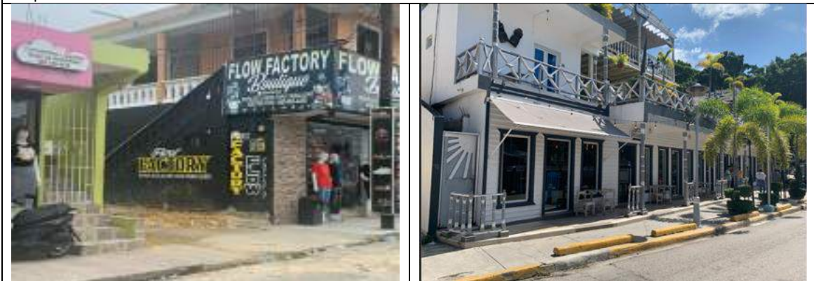
Fotos 13 y 14: Ejemplo de tienda de ropa, también muy común en el recorrido. También se muestra un hotel en Bocachica, que podría verse impactado durante la construcción, ya que la tubería recorre la zona hotelera del distrito.
