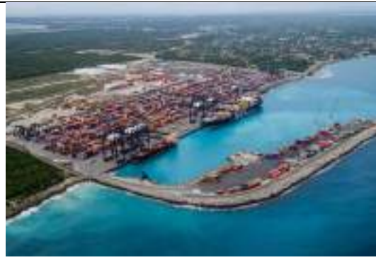
Foto 02: Uso del suelo industrial, Puerto Multimodal Caucedo.
