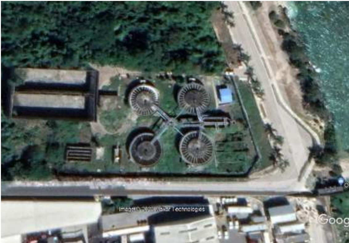
Figura 3.2.1.a Vista de la PTAR existente
