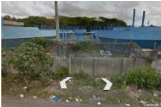
Foto 05: Actual PTAR, inoperante y a ser desmovilizada. En el predio se construirá la EDB-05. Google Street view.
