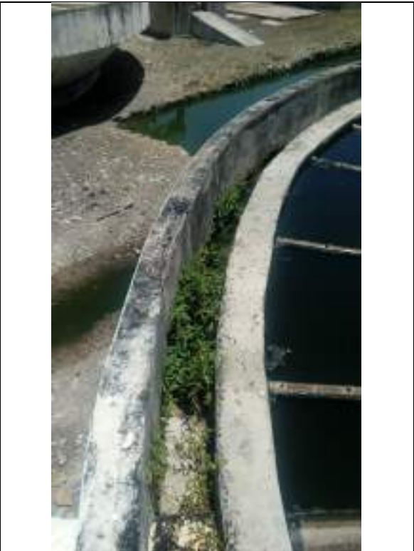
Foto 06: Proliferación de vegetación en decantador.
