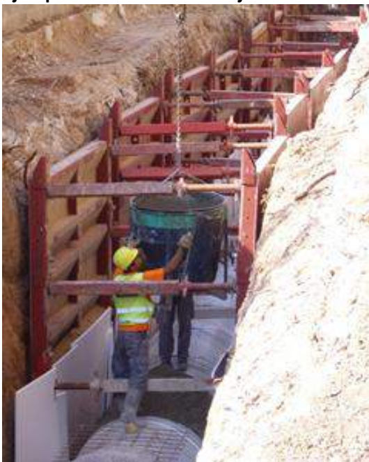
Figura 7.1.b Ejemplo de entibado de zanjas
