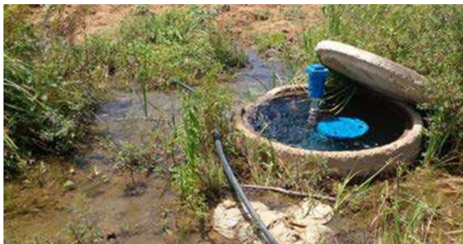
Figura: Ventosa intervenida ilegalmente para mojar una plantación de algodón (Línea B)
