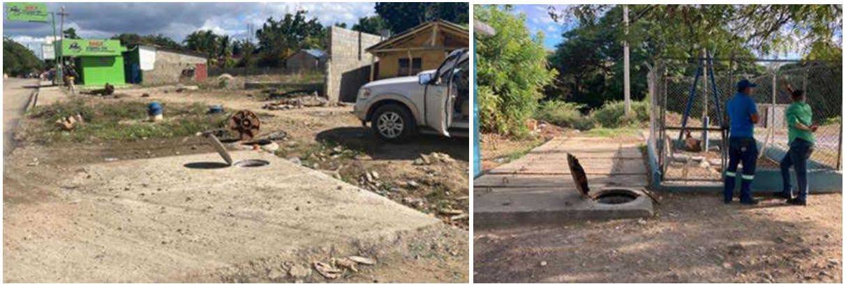
Figura: Cajas de derivación # 15 (Matas de Santa Cruz – Línea A) y 9 (Villa Vásquez - Línea B)
