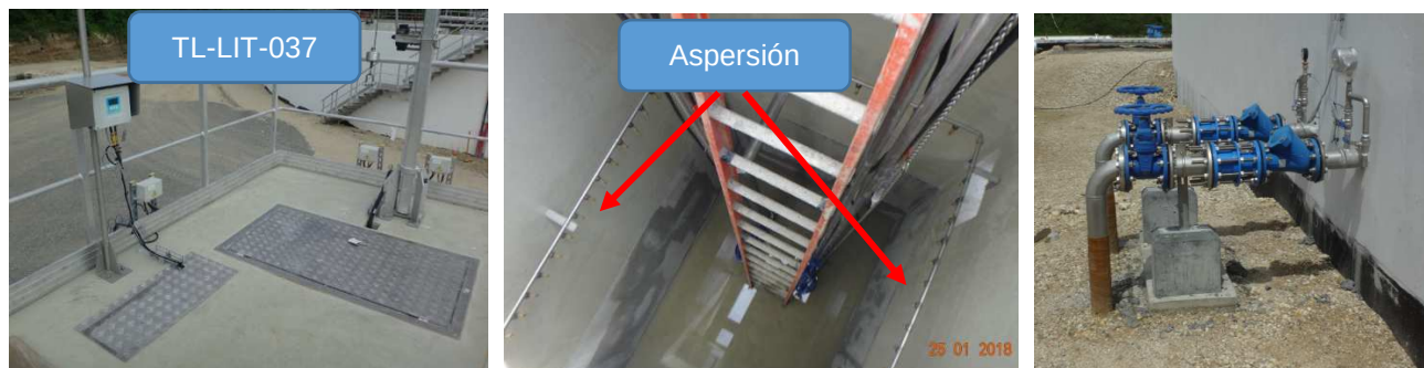
Figura 39. Fotos del pozo de flotantes P005 y del sistema de aspersión
