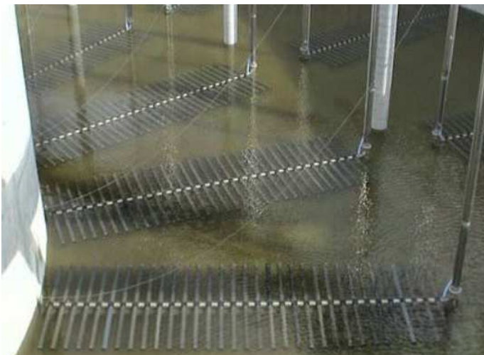
Figura 25. Ejemplo de difusor sumergible
