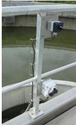
Figura 43. Interruptor y toma para la bomba de vacío
