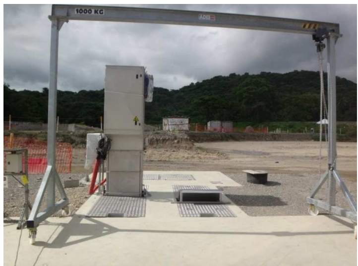
Figura 8. Reja automática de desbaste grueso
