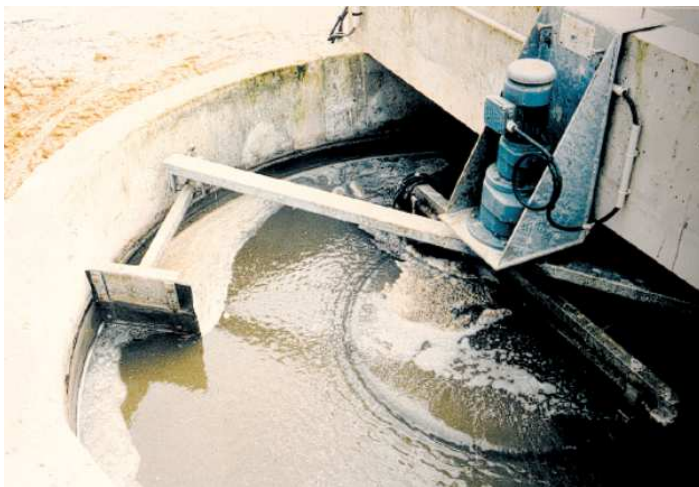
Figura 14. Ejemplo de desarenador con raspado de las grasas
