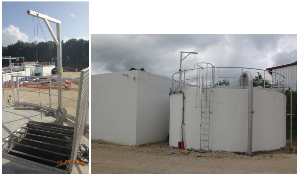
Figura 52. Fosa de homogeneización y tapadera de acceso al agitador TL-AG-203
