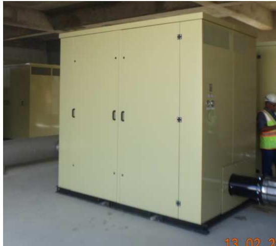
Figura 27. Soplante con carcasa de insonorización y Caudalimetro de aire
