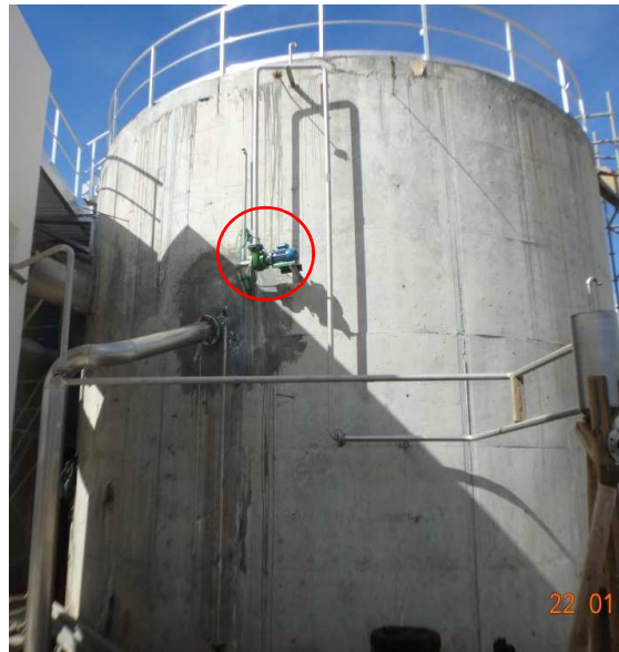
Figura 15. Bomba de extracción de arena
