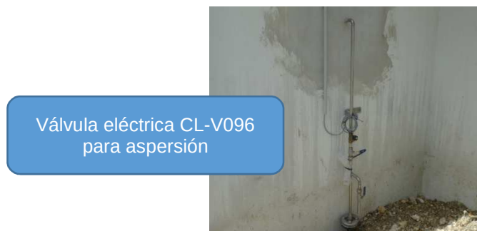
Figura 39. Fotos del pozo de flotantes P005 y del sistema de aspersión
