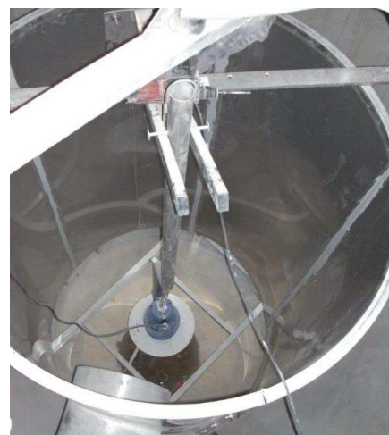
Figura 14. Ejemplo de desarenador con raspado de las grasas
