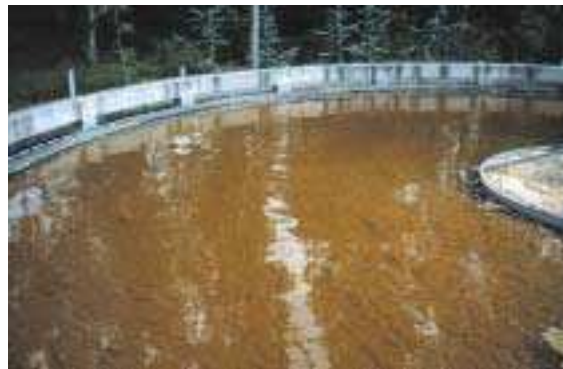
Figure 14– Voile de boue haut dans le clarificateur
