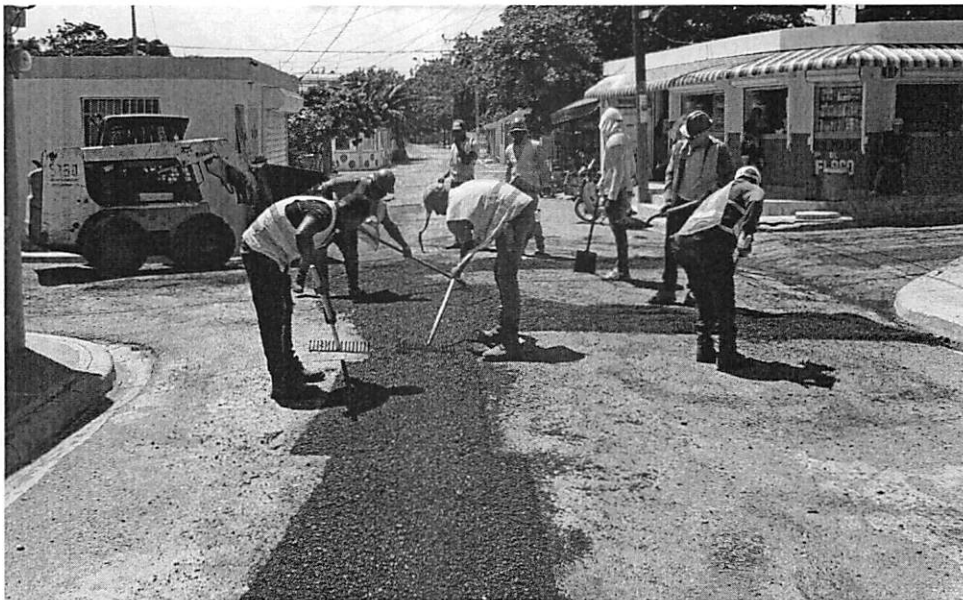
Ilustración 2: Colocación de Asfalto
