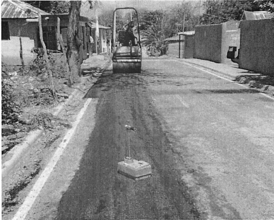
Ilustración 1: Prueba de Compactación con Gamma Densimetro Nuclear
