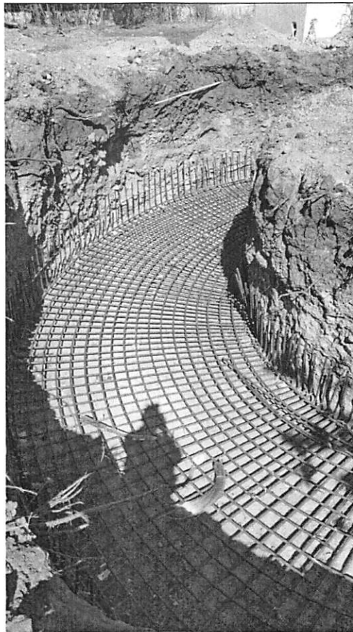
Ilustración 2: Colocación de Acero Zapata Deposito Elevado – Las Tablas
