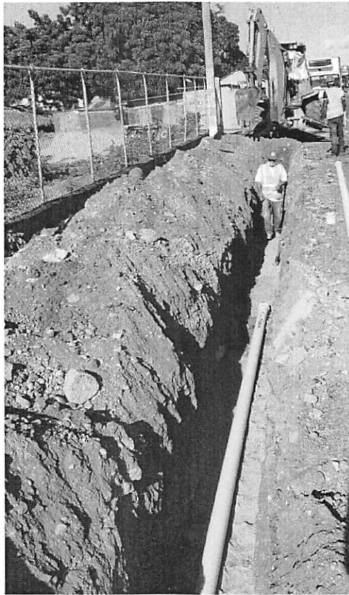
Ilustración 2: Instalación de Tuberías 4" PVC (SDR26) – Sector Rio Arriba
