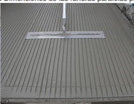
Figura 25. Dimensiones de las ranuras paralelas para pisos de tambo.
