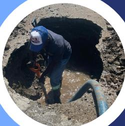
Técnicos de la institución repararon una avería en la línea matriz de distribución de agua potable de dos pulgadas, de PVC, y en la línea recolectora de aguas residuales de 8 pulgadas en la calle Dr. Cabral esquina Caonabo, San Juan de la Maguana.
