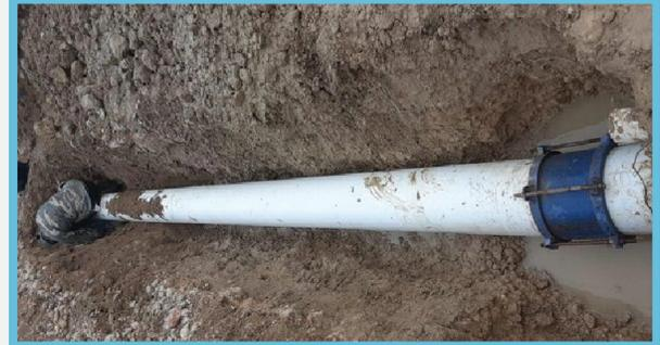
Un equipo técnico reparó una avería en la tubería de 10 pulgadas en el trayecto de Los Limones a Copey.
